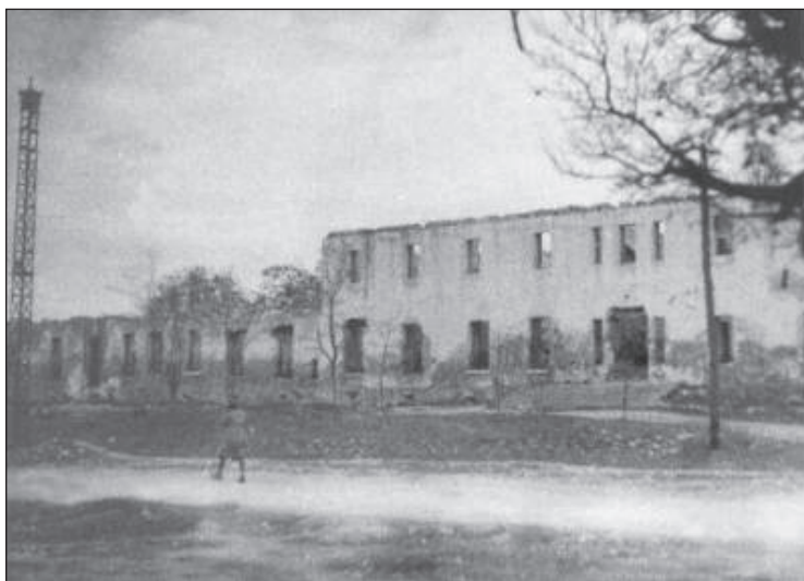
Полуразрушенное здание (ул. Студенческая, 10), где в период оккупации Симферополя находилась служба безопасности. Фото 50-х гг. XX в.
